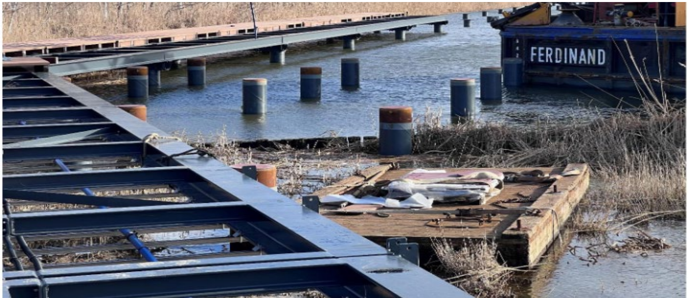
Bild 3 – Gründungspfähle Aussichtsplattform 2
