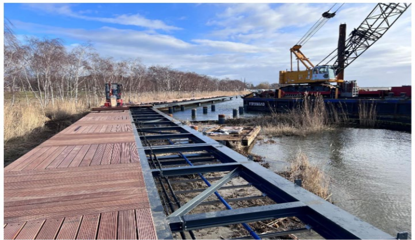
Bild 5: Montage Holzfertigteile WWRPL
