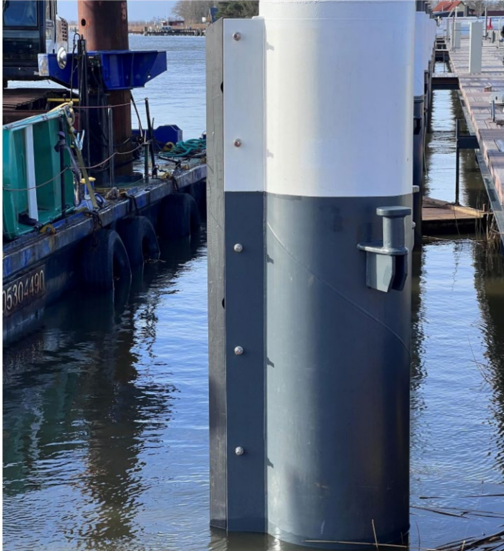
Bild 1 – Montage Fenderleiste
